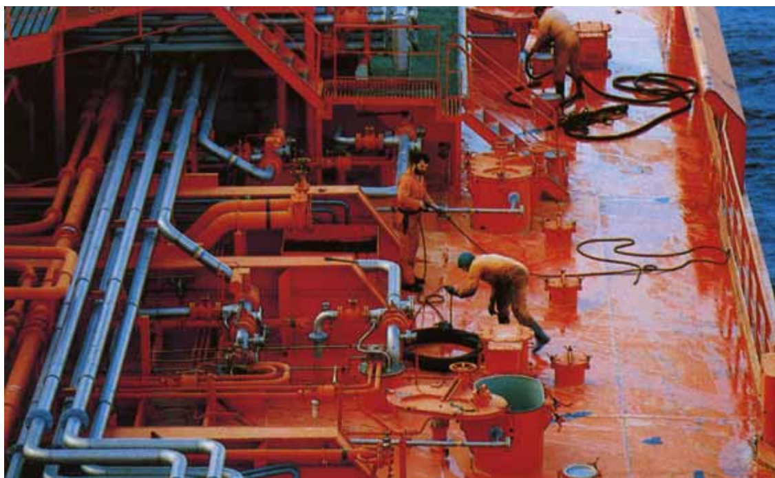
Radarbaserade nivåmätare eliminerade behovet av att öppna tankarna vid underhåll och reparationer.
